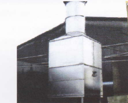
セラマジック・屋外脱臭塔
