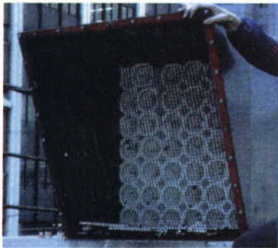
セラブロック・屋外吹出口設置
