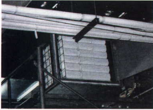
セラブロック・屋内天井吊り下げ
