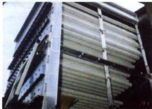
セラマジック・脱臭塔充填・約5000本
